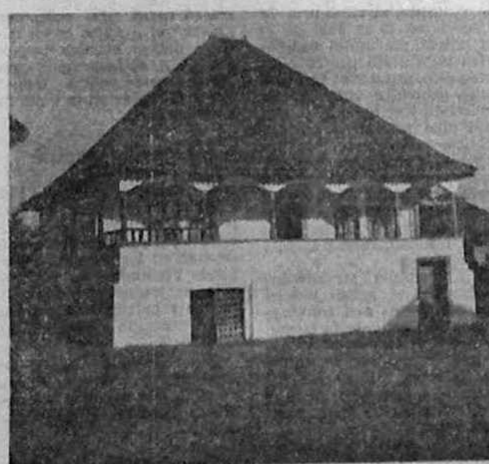
Lumina însăși s-a dizolvat în învelișul de var stins al acestei case din comuna Chiojdu, județul Buzău.
